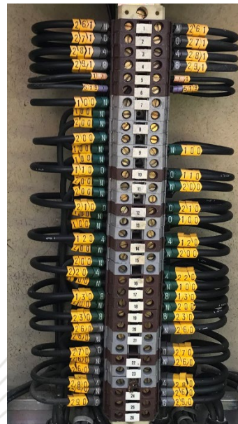
Stezaljke na koje su spojene komande
