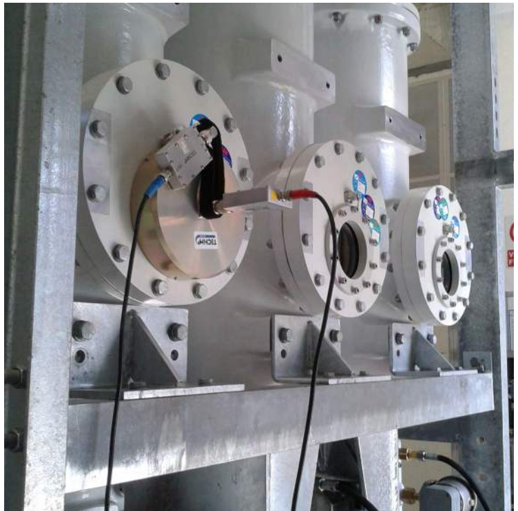
Exemple de capteur UHF adapté aux fenêtres d'inspection
